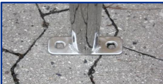
Las placas de montajes pueden utilizar tornillos de base cuadrada o tornillos normales.
